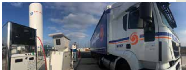
La station multi-énergies permet d'approvisionner sur un même site les véhicules en GNV, bio-GNV, GNL, bio-GNL et azote liquide.
